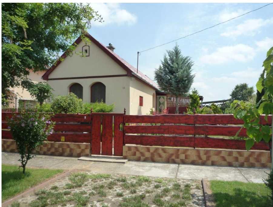
A kerítés formai elemeit és anyaghasználatát, színezését tekintve jól illeszkedik az épülethez
