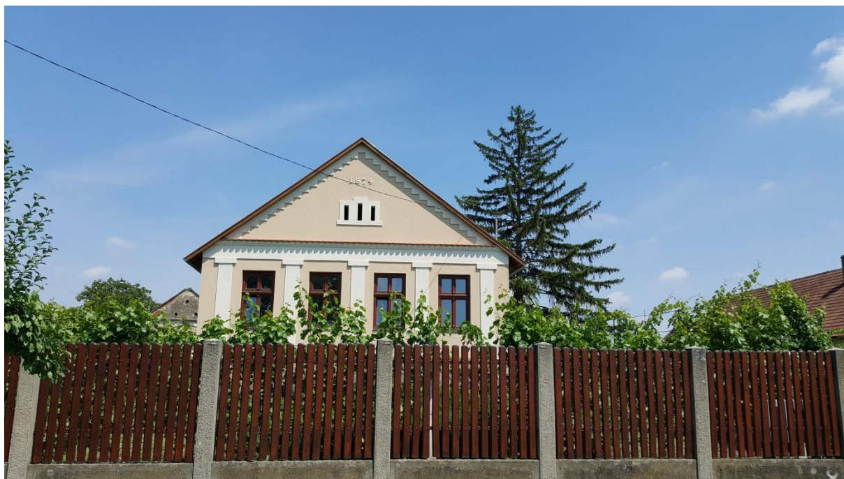
Szabadság u. 17. szépen felújított népi lakóépület
